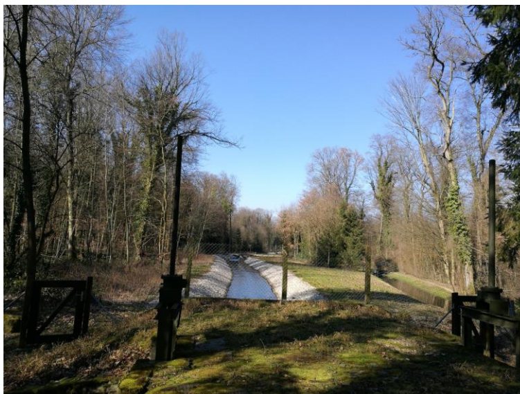
Kanal in der Grundwasserschutzzone
