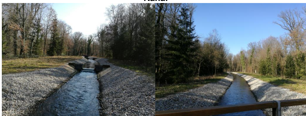
Aussicht auf den mittleren Kanal von der Brücke aus
